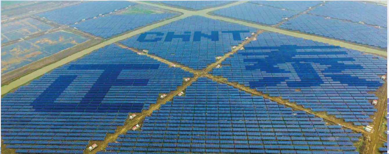
Astronergy 150 MW - Estación de Energía Solar - Wenzhou, China
